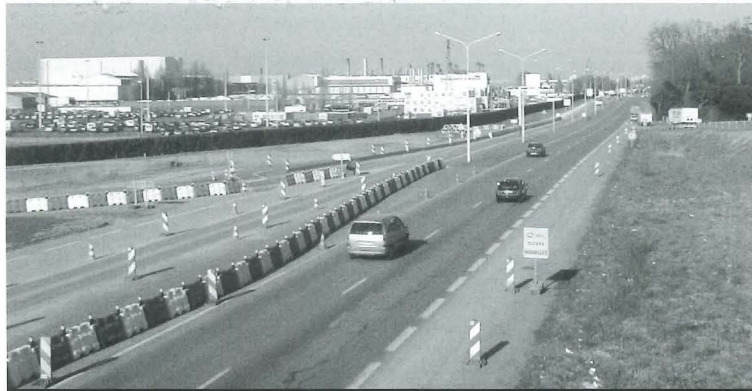
Les travaux de l'échangeur de la Croix aux Potiers sont suspendus.
