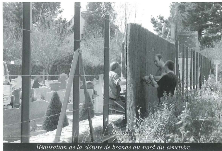
Réalisation de la clôture de brande au nord du cimetière.
