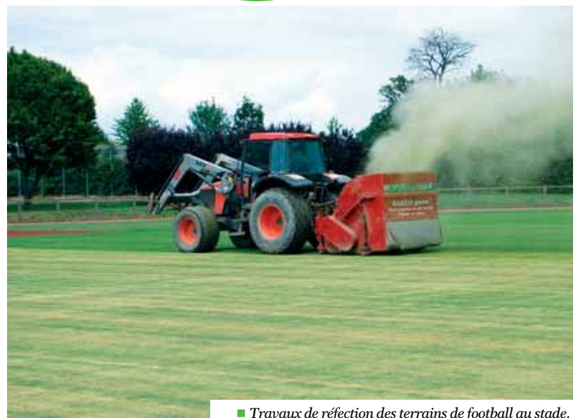
■ Travaux de réfection des terrains de football au stade.
