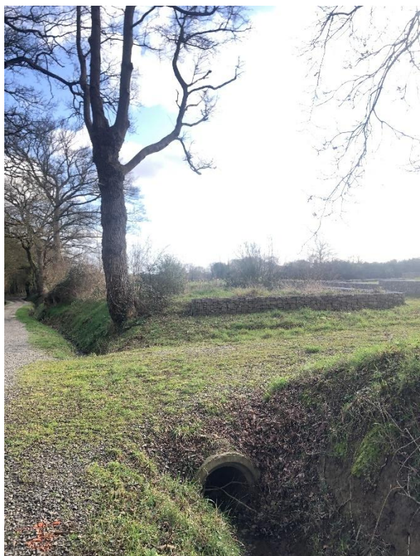
Séquence 3 – raccordement sur le chemin existant
