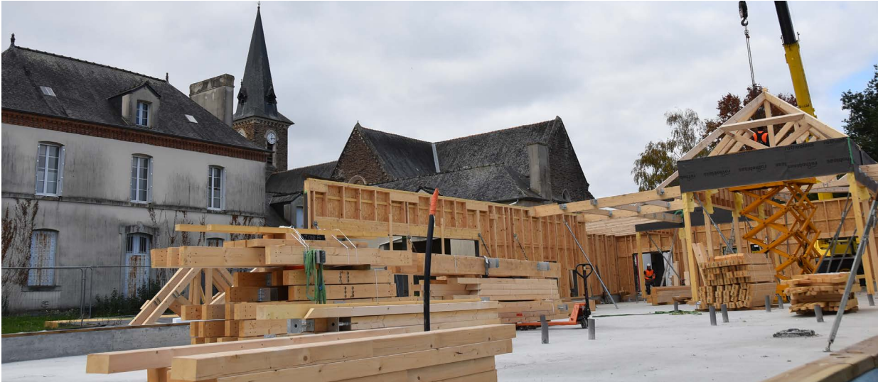
■ Les travaux de la future crèche qui ouvrira à l'été 2026 continuent avec la pose des murs et des charpentes bois.
