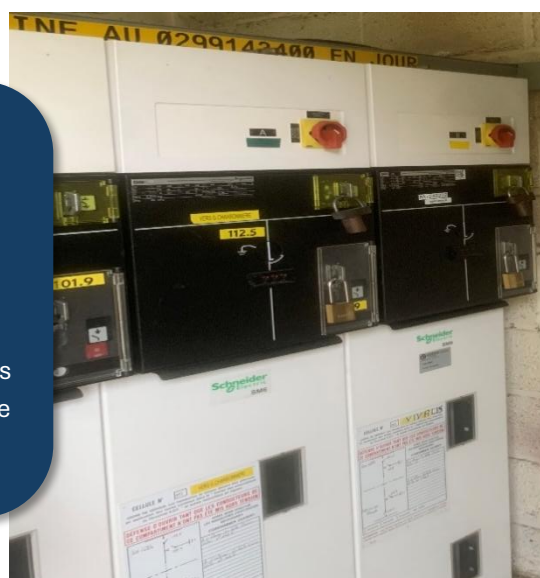
Vue de face des cellules motorisées installées au site des Galets
