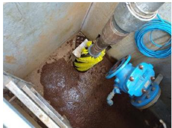
Travaux de nettoyage du forage du Rocher : à gauche : Sortie de la pompe ; à droite : passage de la brosse en nylon dans le tubage
