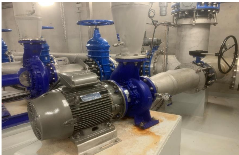
Vue au premier plan de la turbine installée à Villejean
