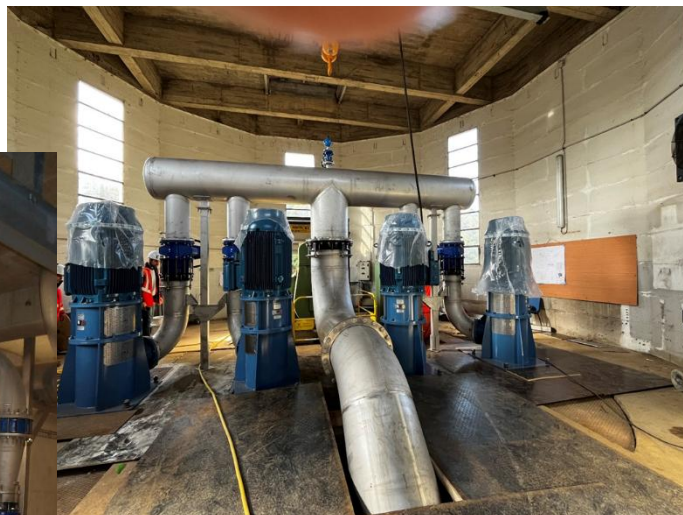
Pompes de prélèvement de l'eau dans le barrage
