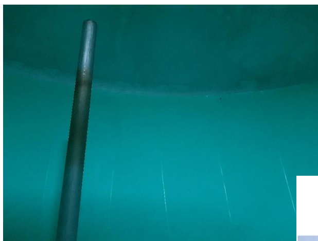
Le réservoir de Chavagne avec une réhabilitation complète et mise en place d'une membrane pour assurer l'étanchéité de l'ouvrage.
