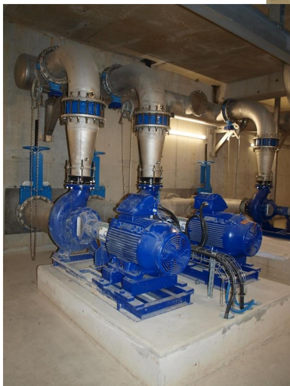
Pompes de lavage des filtres
