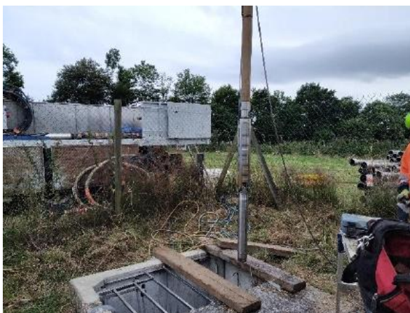
Travaux de nettoyage du forage du Rocher : à gauche : Sortie de la pompe ; à droite : passage de la brosse en nylon dans le tubage
