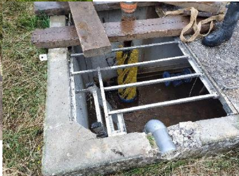
Passage de la brosse nylon dans le tubage du F2 bis
