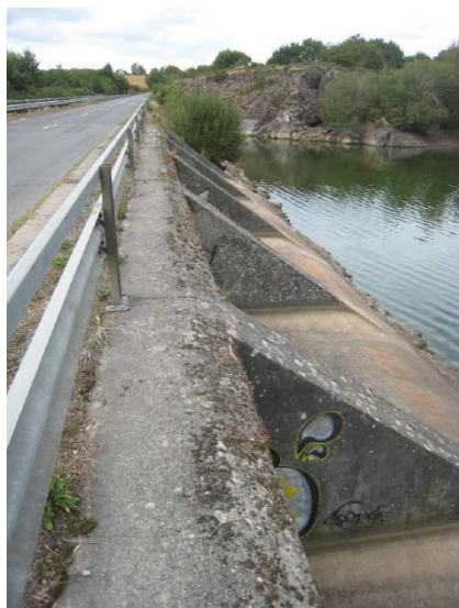
Barrage de Pont-Muzard-Vue aval des évacuateurs de crue
