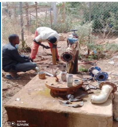
Dankassari (Niger) – Tête de forage sur une mini AEP - les conduites et pièces défectueuses sont démontées et remplacées
