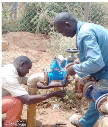
Dankassari (Niger) – Tête de forage sur une mini AEP - les conduites et pièces défectueuses sont démontées et remplacées
