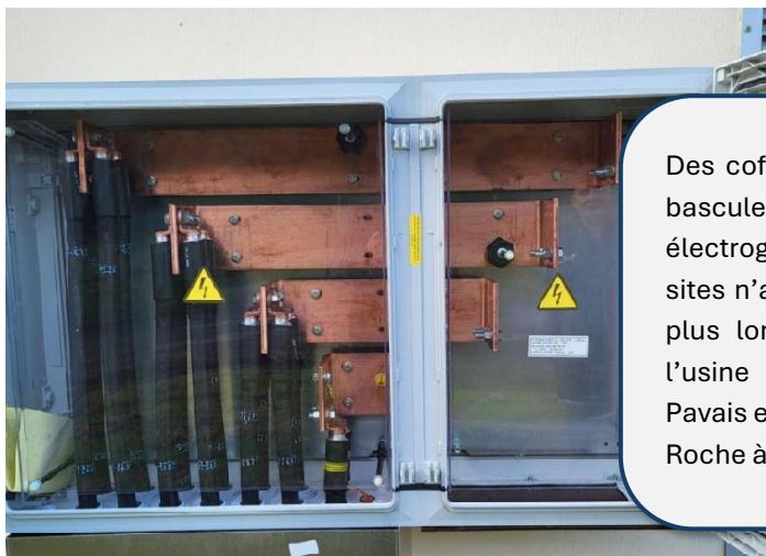
Vue de face du coffret de raccordement BT installé à Mézières sur Couesnon
