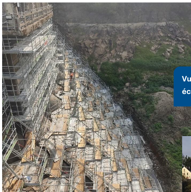
Vue du parement amont équipé du dispositif d'étanchéité depuis la tour d'exhaure.
