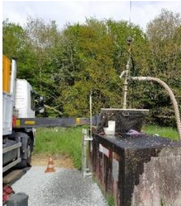
Travaux de nettoyage des forages F2 bis et F3 : Air-lift forage F2 bis
