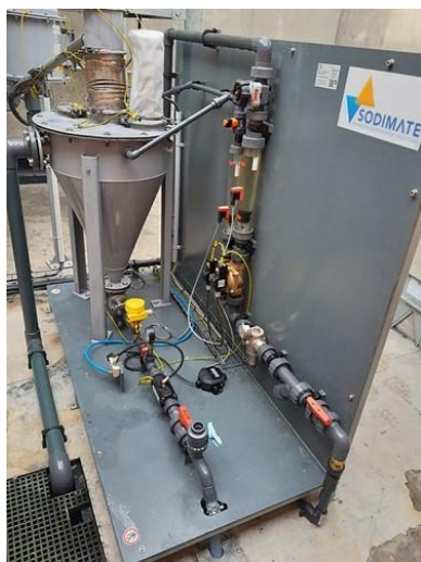
Nettoyage des forages de Feins et nouveau système d'injection de CAP à l'usine de la Douettée
