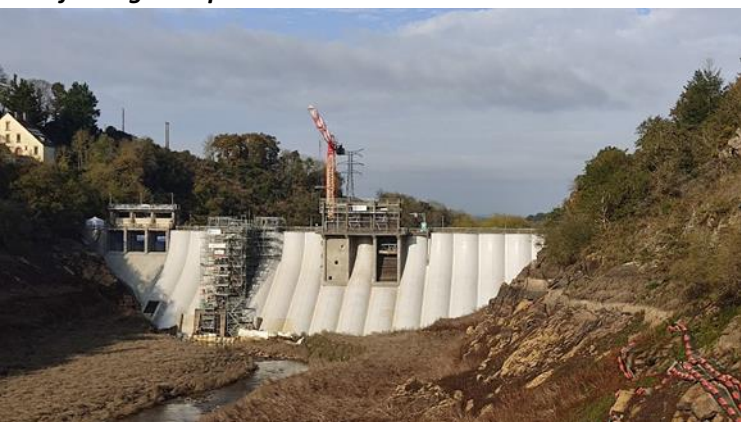
Vue à l'amont du barrage avec le nouveau revêtement d'étanchéité
