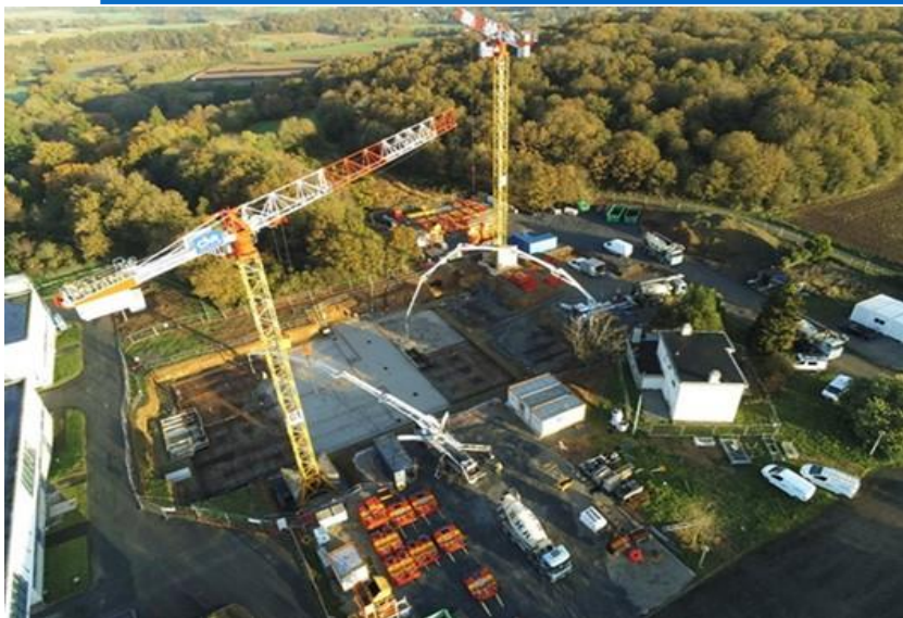
Coulage du radier du nouveau bâtiment de traitement Rophémel
