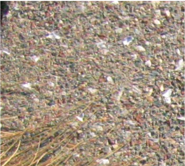
béton coulé en place agrégat clair
