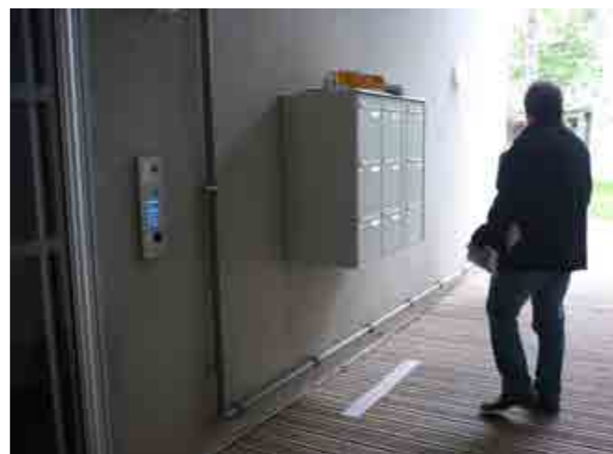
Regroupement de boîtes aux lettres sous porche d'accès aux logements
