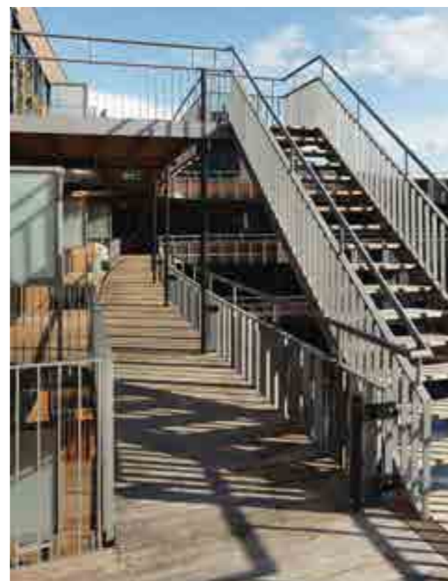
Des coursives désolidarisées de l'enveloppe du bâti pour supprimer les ponts thermiques
