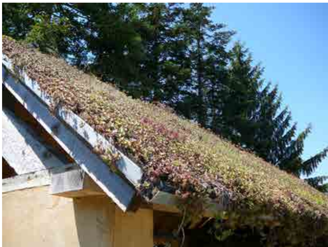
Toiture végétalisée en pente, Bazouges-sous-Hédé (Ille-et-Vilaine)
