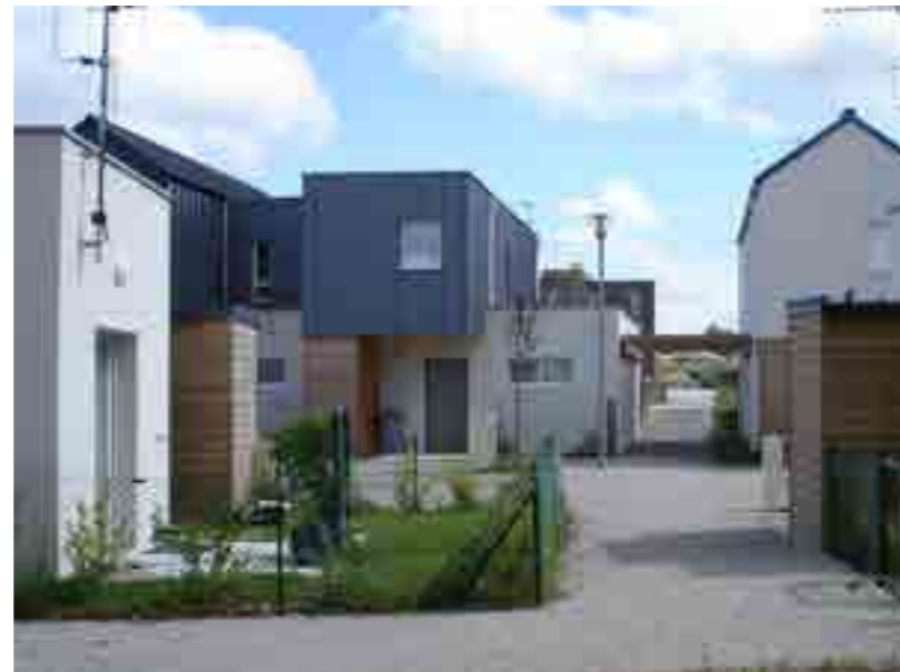
Quartier de la Bottière Chesnaie_Nantes (44)
