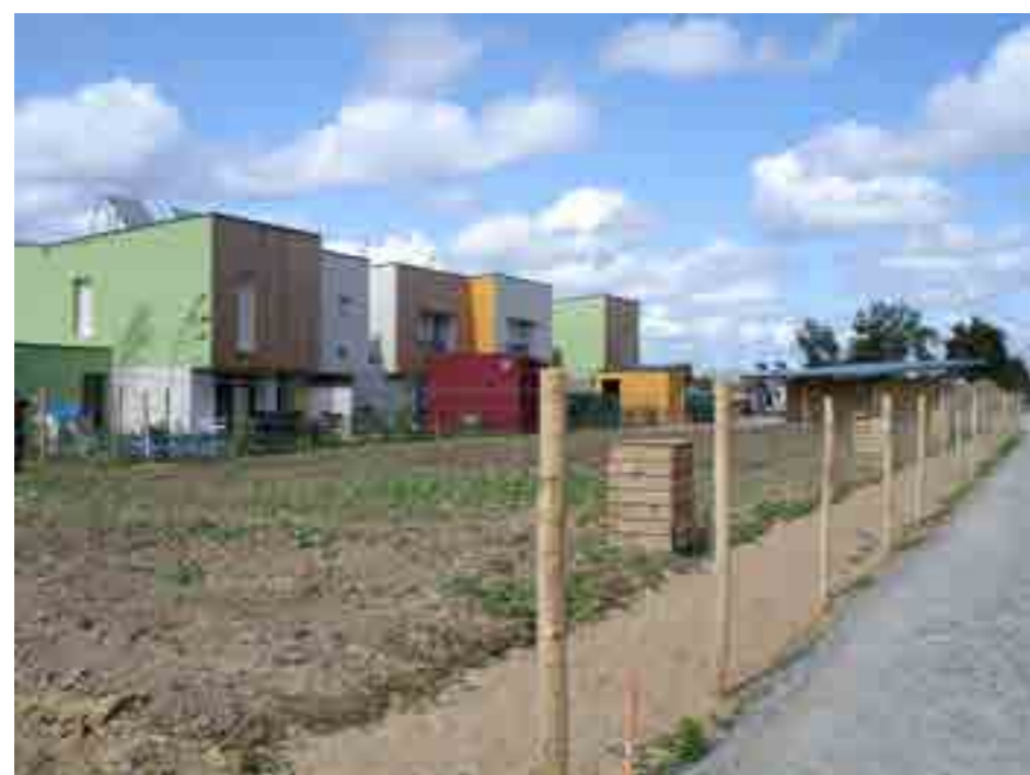
Toiture terrasse, volume simple
