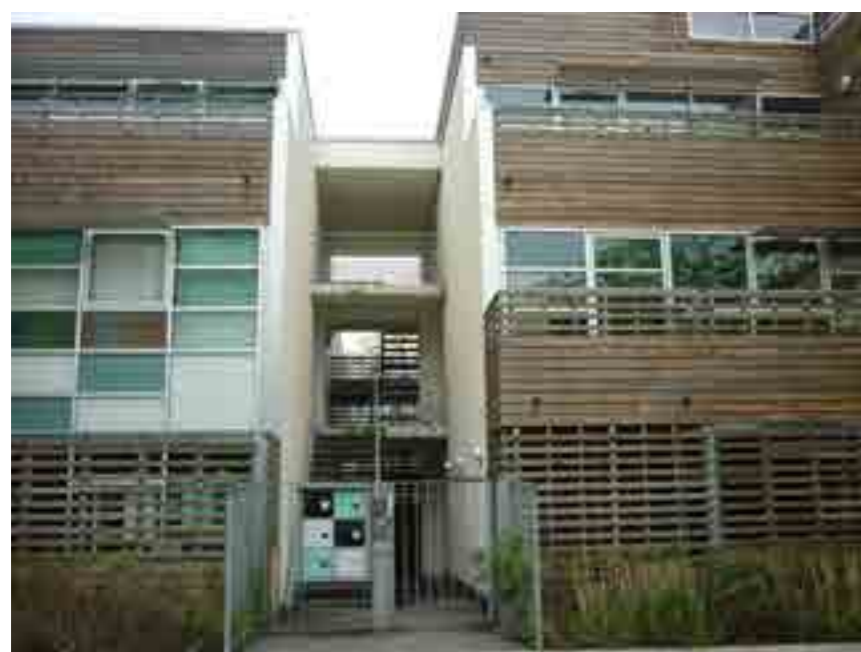
Regroupement de boîtes aux lettres intégré dans la clôture
