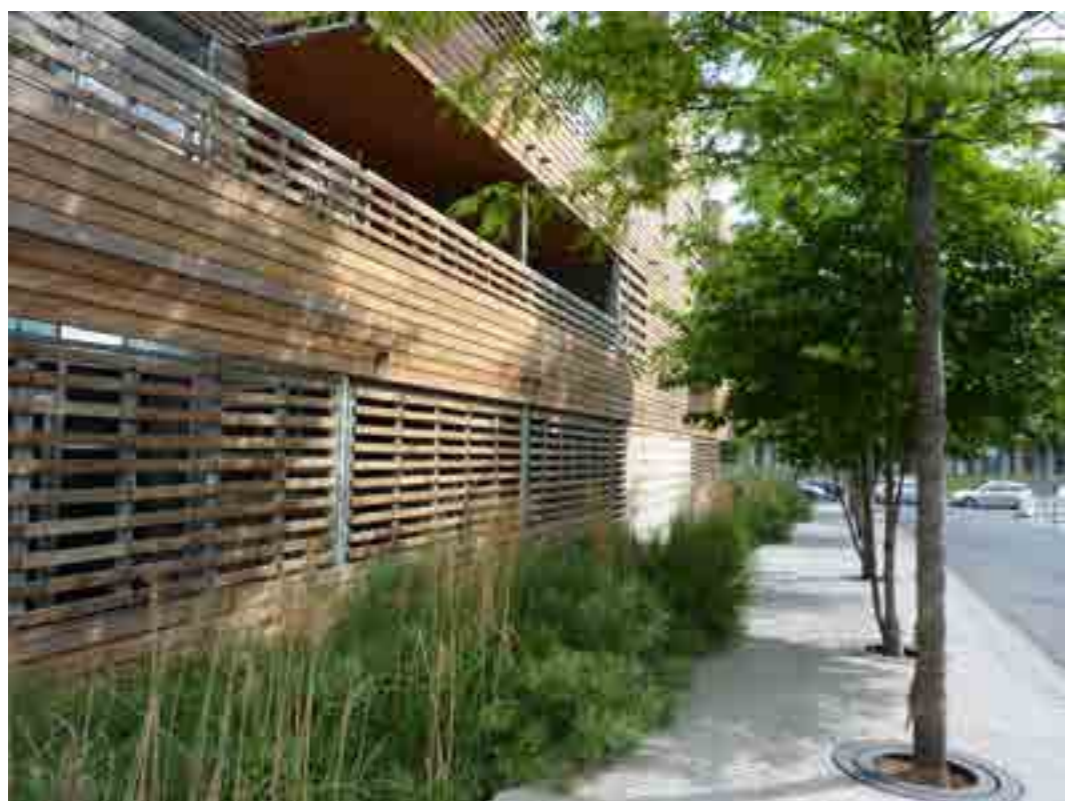
Logements collectifs, le bois habité, Lille, architectes Dusapin Leclerc
