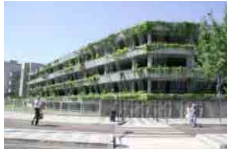
Parking silo simple végétalisé
