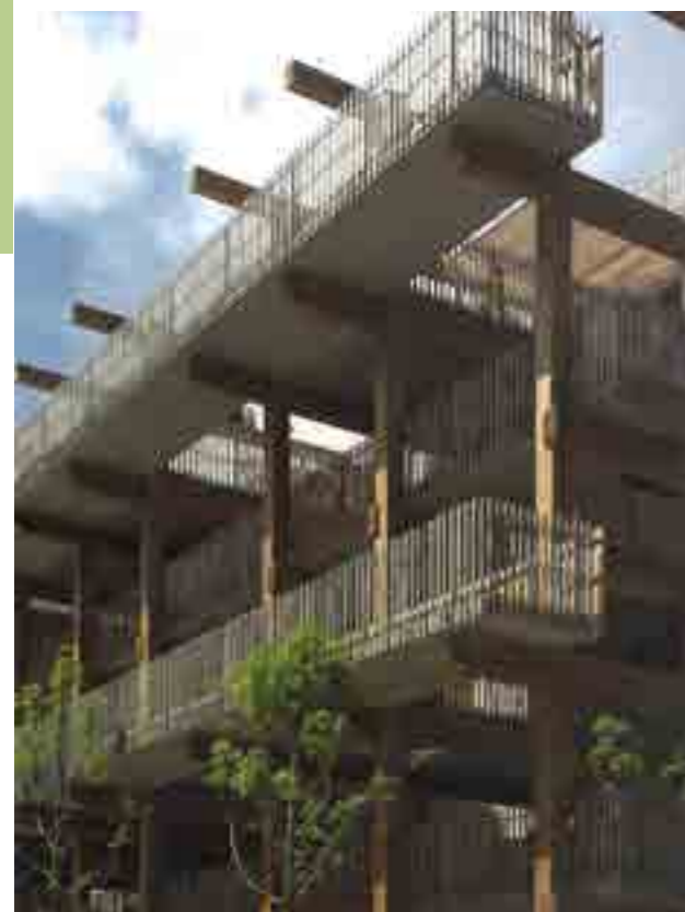
Des coursives désolidarisées de l'enveloppe du bâti pour supprimer les ponts thermiques
