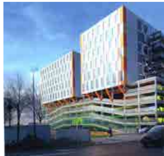
Parking silo habité au-dessus, Fgp, Nantes
