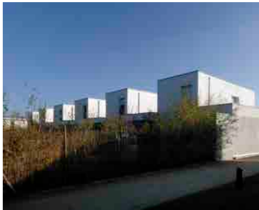
Quartier de la Bottière Chesnaie_Nantes (44)
