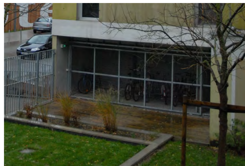
quartier du Bois Habité, Lille (59) architectes : de Alzua +
