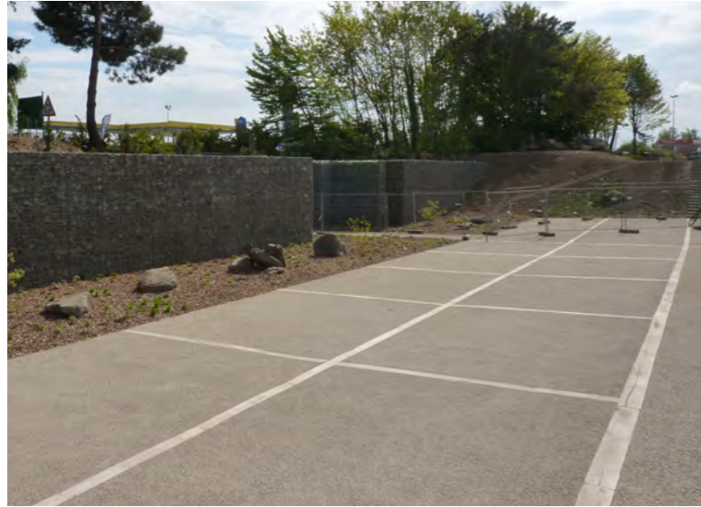
béton coulé en place, joint bois
