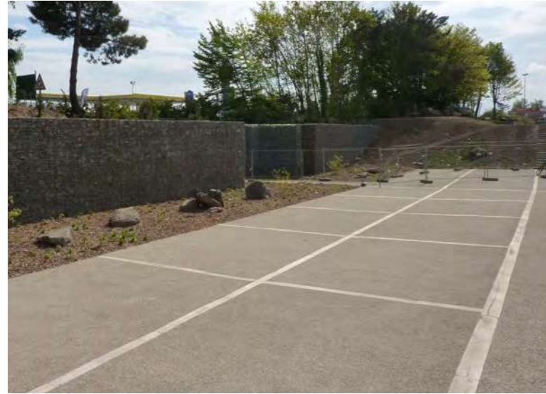
béton coulé en place, joint bois
