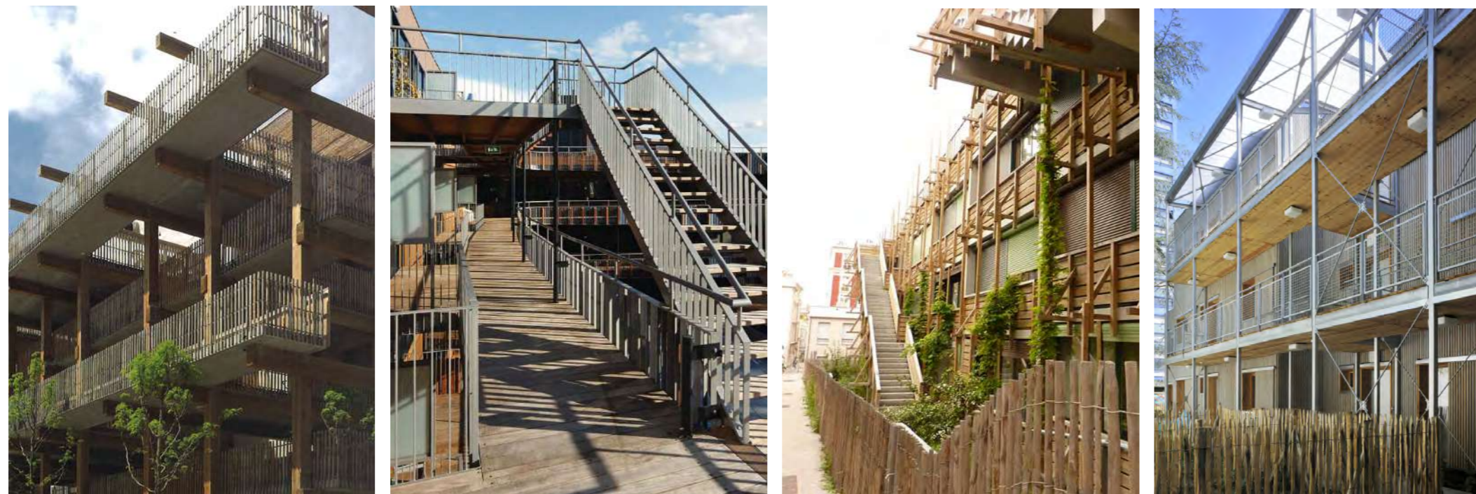
Des coursives désolidarisées de l'enveloppe du bâti pour supprimer les ponts thermiques et favoriser les intimités des logements. Utiliser les coursives pour faire participer le végétal au prolongement extérieur du logement
