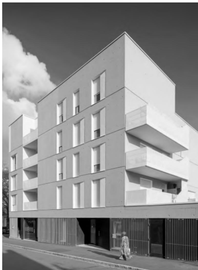
2 projets à Nantes (44) / architecte : JBA
