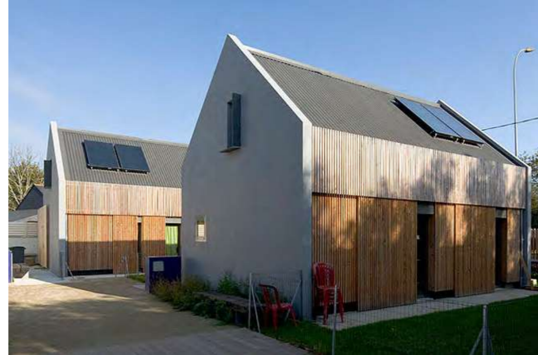
exemple de panneaux solaires intégrés sur toiture double pente architectes : JBA / Treillières (44)
