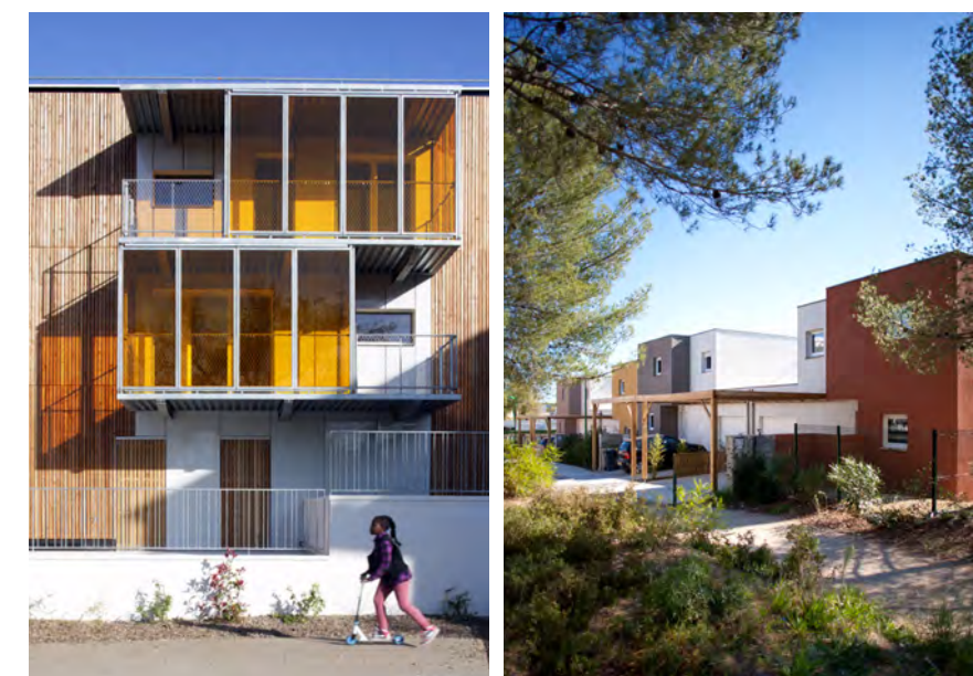
Ecoquartier / Île Saint-Denis (93) architecte : Philippon Kalt
