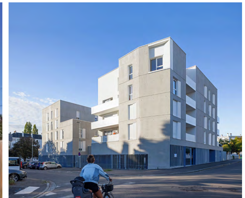
Logements collectifs R+4 maximum architecte : JBA / Nantes (44)
