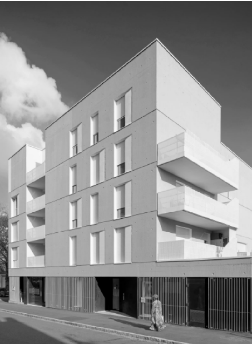
2 projets à Nantes (44) / architecte : JBA
